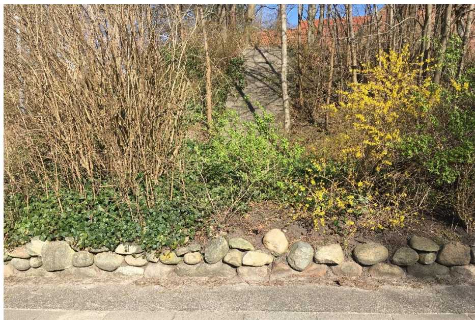
Betondækningsgraven som den så ud i 2020.
